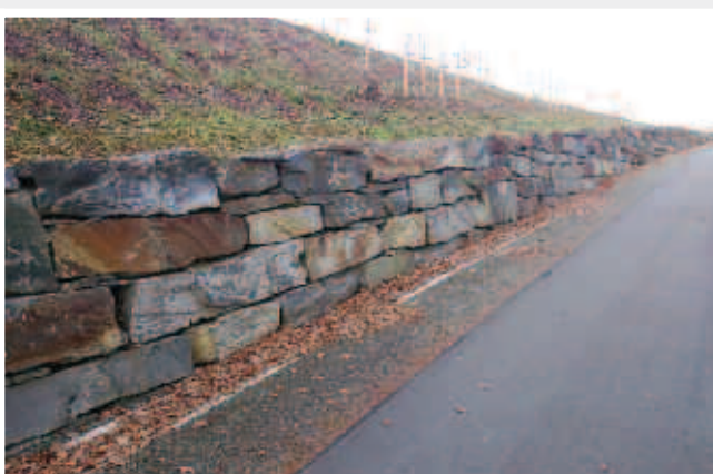
Bruchsteinmauerwerk „grossformatig“ „Theumaer Fruchtschiefer“
