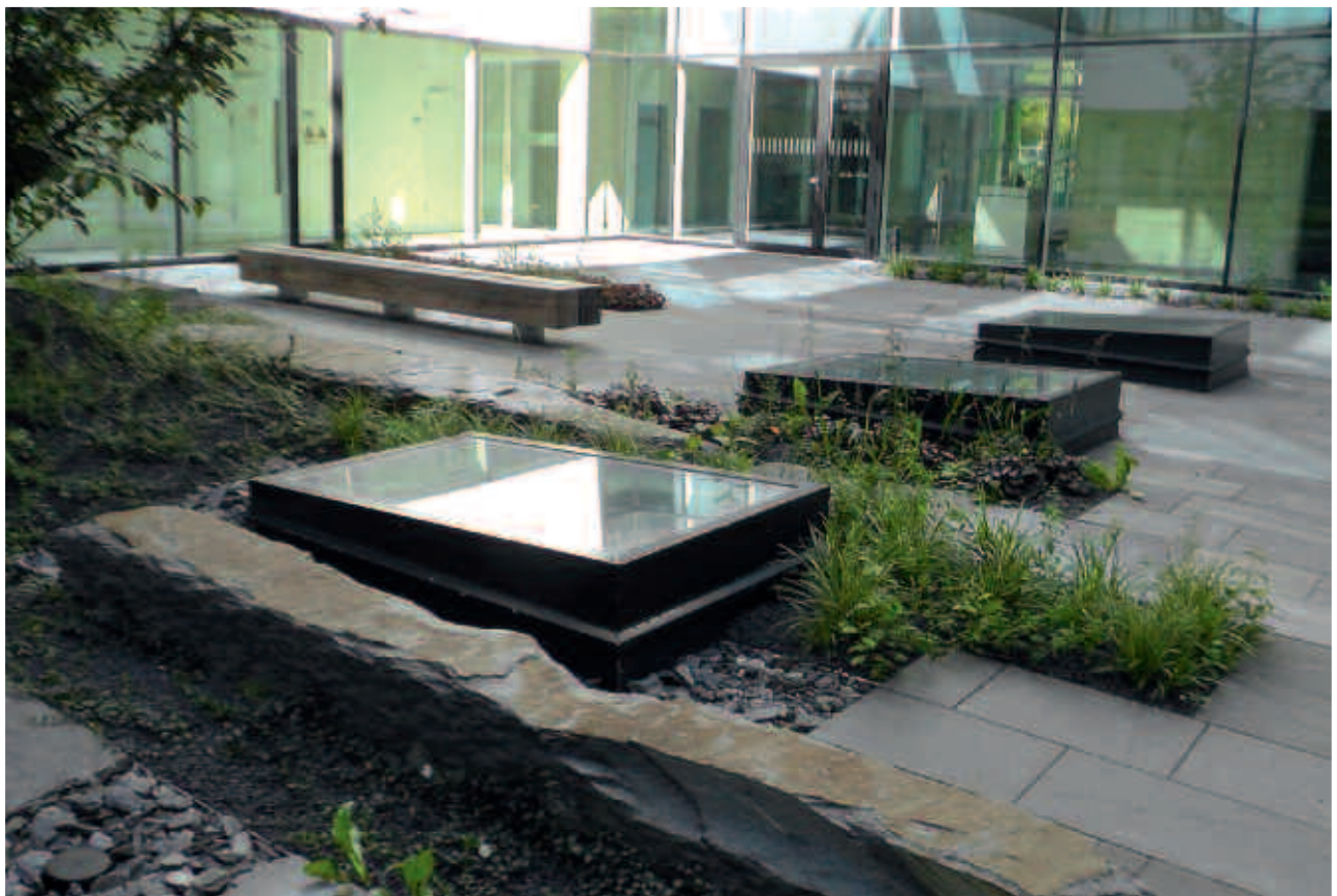
München, Centrum für Schlaganfall- und Demenzforschung (CSD) Bodenplatten „geflammt“, „gespalten“, Planung Horst Kübert, Dipl.-Ing. FH, Landschaftsarchitekt bdla, 80337 München Stelen (liegend), Ausführung Josef Saule GmbH, 86169 Augsburg Ziersteine „gebrochen“
