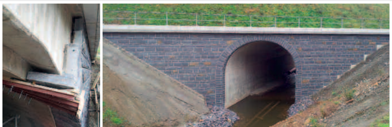
Schleiz-Görkwitz, Bundesautobahn A9, Brücke BW 154a Planung Wayss & Freytag Ingenieurbau AG, 60489 Frankfurt/Main Ausführung Natursteinwerk Theuma GmbH, 08541 Theuma
