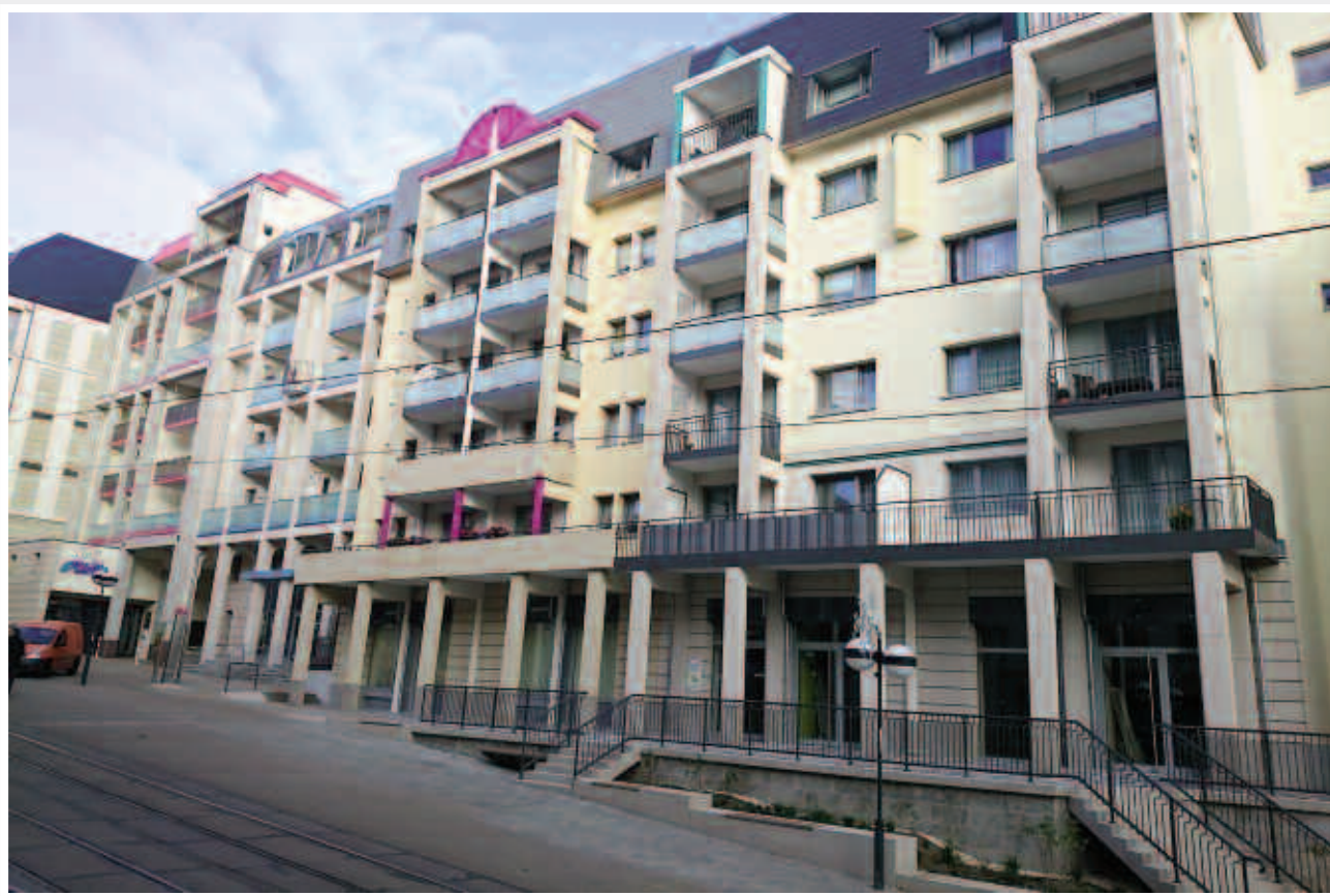
Plauen, Umbau Wohnhaus Bahnhofstraße 26 Wand-, Stützen- und Riegelverkleidung aus Planung Planungs- und Ingenieurbüro EGER, BEER & Partner GbR, 08525 Plauen „Flossenbürger Granit“ und „Cottaer-/Postaer Sandstein“
