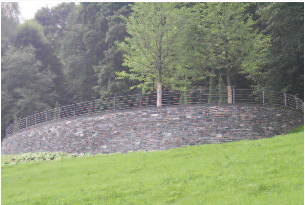
Reichenbach, Landesgartenschau 2009 Mauerwerk Planung geskes.hack Landschaftsarchitekten GmbH, 14059 Berlin Ausführung Natursteinwerk Theuma GmbH, 08541 Theuma
