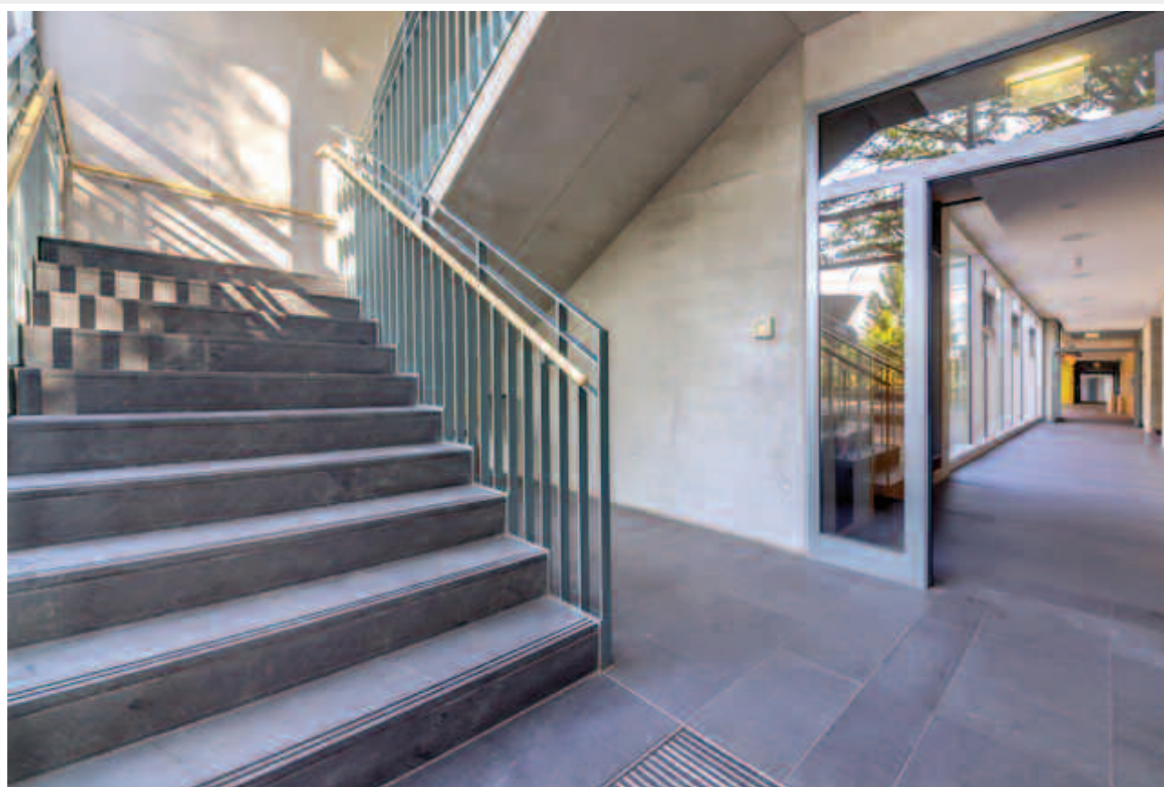
Oberasbach, Sonderpädagogisches Förderzentrum Planung Bernhard Heid Architekten BDA, 90768 Fürth Ausführung Oliver von Delius Garten-, Landschafts- und Sportstättenbau, 90427 Nürnberg
