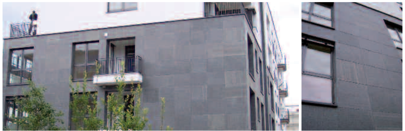
München, Wohnhaus Ausführung Wirth Naturstein GmbH, 97816 Lohr-Ruppertshütten
