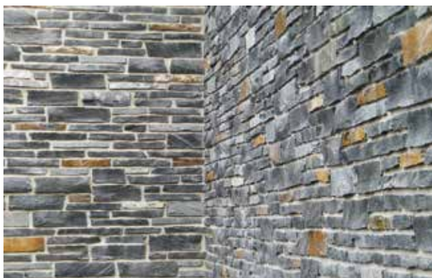
Fruchtschiefer in einer weiteren Facette: Im Bereich der Wasserfälle wurde eine Wand mit dem Naturstein gestaltet
